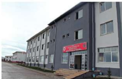
Bandırma Açık Ceza İnfaz Kurumu
