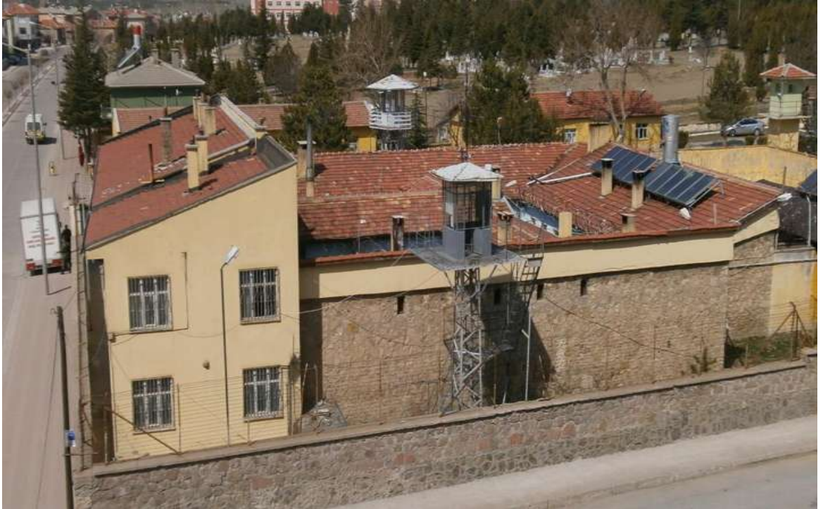
Seydişehir B Tipi Ceza İnfaz Kurumu
